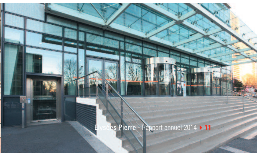
78/80, Avenue du Général de Gaulle - Bagnolet (93)
